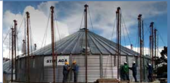
Ensemble complet d'outils pour le montage du silo.
