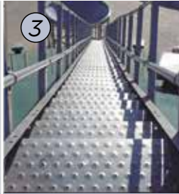
ESCALIER SUR TOIT
