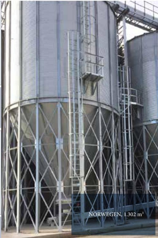
Der Trichter besteht aus Segmenten, die aus **Baustahl S 350 GD – Z600** hergestellt werden. Sie können mit einem **Winkel von 45°, 60° oder 66°** angefertigt werden, je nach dem Fließvermögen des gespeicherten Schüttgutes.
