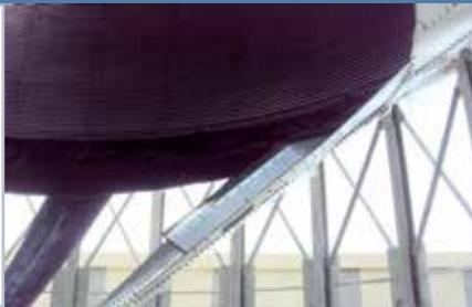
Bestehend aus einem perforierten Lüftungskanal der zu einem Sektor der Trichter befestigt ist, vollständig vorbereitet für Ventilatoranschluss.
