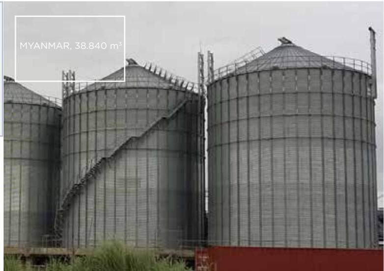
• **Mit einem Sicherheitsring und Plattformen**, Geländerstangen und rutschfesten Stufen. Sie erfüllen sämtliche geltenden Sicherheitsvorschriften (UNE EN ISO 14122-1/2/3/4:2002).
