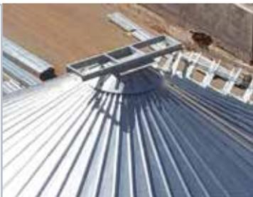
Halterung am Dach für den Laufsteg, verzinkt.
