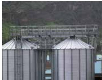
Ermöglicht den Zugriff auf die Inspektionsluke.
