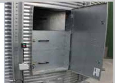
Die den Zugang zum Silo erleichtert. Befindet sich im ersten und zweiten Ring. Die Tür ist in 3 Abschnitte unterteilt, um den Verlust von Getreide zu verhindern
