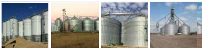
KOLUMBIEN 28.965 m³ CHILE 52.316 m³
