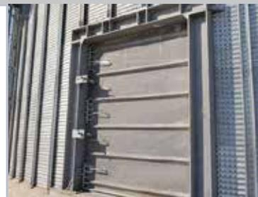
Permitir a passagem de máquinas para o silo. Com placa de ancoragem ao chão e reforços. Inclui um sistema de fechamento. Acabamento galvanizado.
