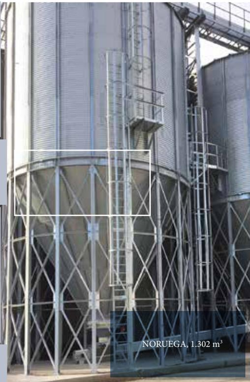
A tremonha é composta por setores de aço estrutural **S 350 GD-Z600**, podendo ser confeccionada com ângulos de **45°, 60° ou 66°**, dependendo da vazão do fluxo do material armazenado..
