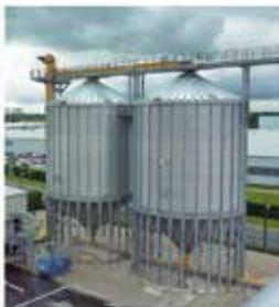
**SILOS COM TREMONHA INFERIOR METÁLICA, COM ÂNGULOS DE 45° OU 60°** DEPENDENDO DA FLUIDEZ DO PRODUTO ARMAZENADO, POR DESCARGA GRAVITACIONAL
