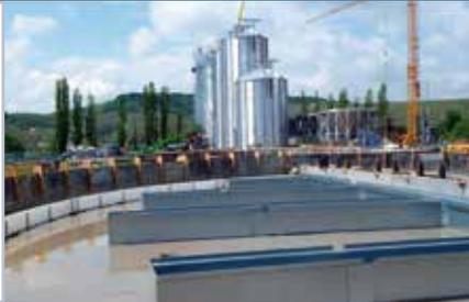
Fabricado em chapa de metal com 3 mm de espessura, dependendo do tamanho, largura e profundidade do volume de grão a ser armazenado. Disponível para sistemas de aeração tipo "Y", "H" e "C".
