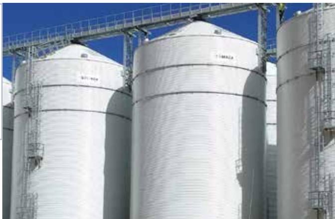
O revestimento externo adiciona proteção contra corrosão, proporcionando isolamento extra. Disponível para telhado, cilindro e tremonha, nas cores branco, verde e azul.
