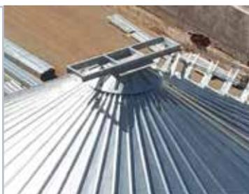
Soportes galvanizados en cúpula de silo para transportador.
