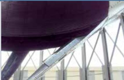
Sistema que consiste en un canal de aireación con perforaciones, fijado a un sector de tolva preparado para la conexión del ventilador.
