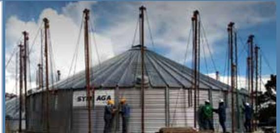
Material auxiliar para el montaje del silo.
