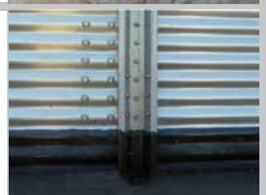
Pintura bituminosa para el sellado de la cimentación.
