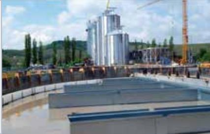
Fabricadas en chapa de 3 mm. de espesor, dependiendo del tamaño, el ancho, y la profundidad, del volumen de grano a almacenar. Disponibles para sistemas de aireación tipo "Y", "H" y "C".
