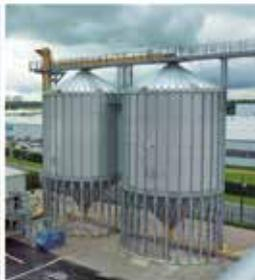
**SILOS CON TOLVA METÁLICA INFERIOR, CON ÁNGULOS DE 45° O 60°** EN FUNCIÓN DE LA FLUIDEZ DEL PRODUCTO ALMACENADO, POR DESCARGA POR GRAVEDAD
