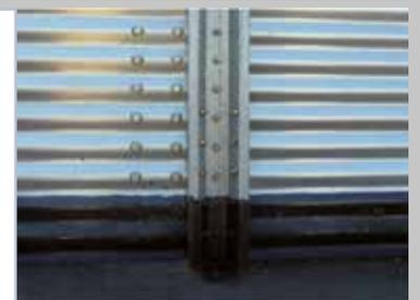
Bitumen-Färbung zur Abdichtung der Fundamente.
