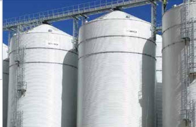
Die Aussenverkleidung bildet einen zusätzlichen Rostschutz. Durch die auf diese Weise geschaffene Luftkammer wirkt sie darüber hinaus als zusätzliche Wärmeisolierung. Verfügbar für Dach, Zylinder und Trichter, in weisser, grüner oder blauer Farbe.
