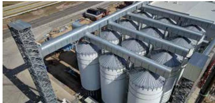
Laufsteg Norm UNE En ISO 14122-1. Standardboden und Gitterrost, Modulares System anpassbar an die Installation. Option Geschlossenen Laufsteg.
