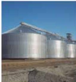
**SILOS MIT FLACHEM ODER KEGELFÖRMIGEM BODEN AUS BETON FÜR DIE LAGERUNG GROSSER MENGEN VON KÖRNIGEM SCHÜTTGUT ODER SAMEN ÜBER EINEN LANGEN ZEITRAUM**
