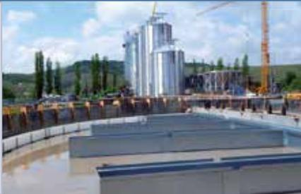
Diese Gossen befinden sich im Fundament des silos. Gefertigt mit einer Dicke von 3mm, je nach Grösse, Breite und Länge des Getreidevolumens. Verfügbar für Belüftung Type "Y", "H" und "C".
