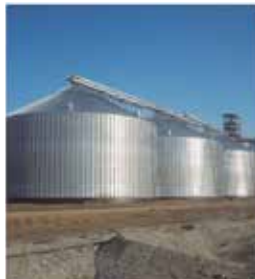
SILOS MIT FLACHEM ODER KEGELFÖRMIGEM BODEN AUS BETON FÜR DIE LAGERUNG GROSSER MENGEN VON KÖRNICEM SCHÜTTGUT ODER SAMEN ÜBER EINEN LANGEN ZEITRAUM
