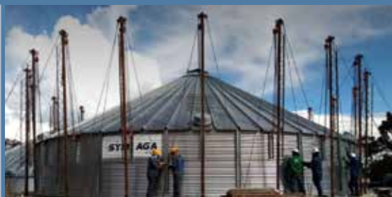
Material auxiliar para el montaje del silo.
